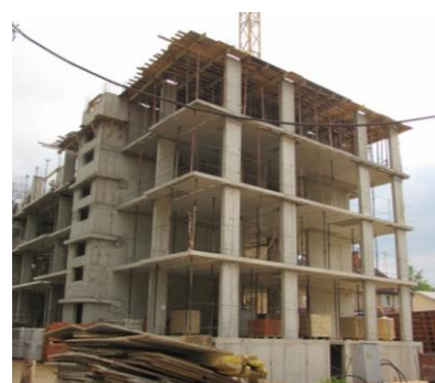
Рис. 84 Строительство дома из железобетонных конструкций
